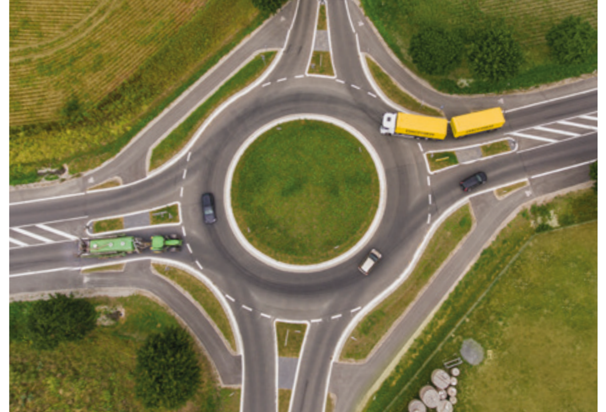
Innerhalb nur eines Jahres von der Planung bis zur Fertigstellung konnte der Kreisverkehr in Westenholz verwirklicht werden.
