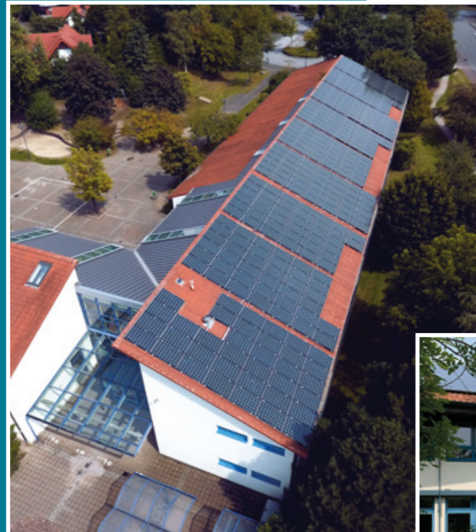
Auf Antrag der CDU wurde mit allen Fraktionen im Rat der Stadt Delbrück eine Klimakommission auf den Weg gebracht. Besondere Priorität hat der Bau und Betrieb von Photovoltaikanlagen auf öffentlichen Gebäuden, wie zum Beispiel auf dem Dach der Johannes-Schule in Delbrück.
